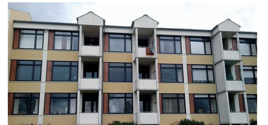
HAB boligblok som får nye vinduer
